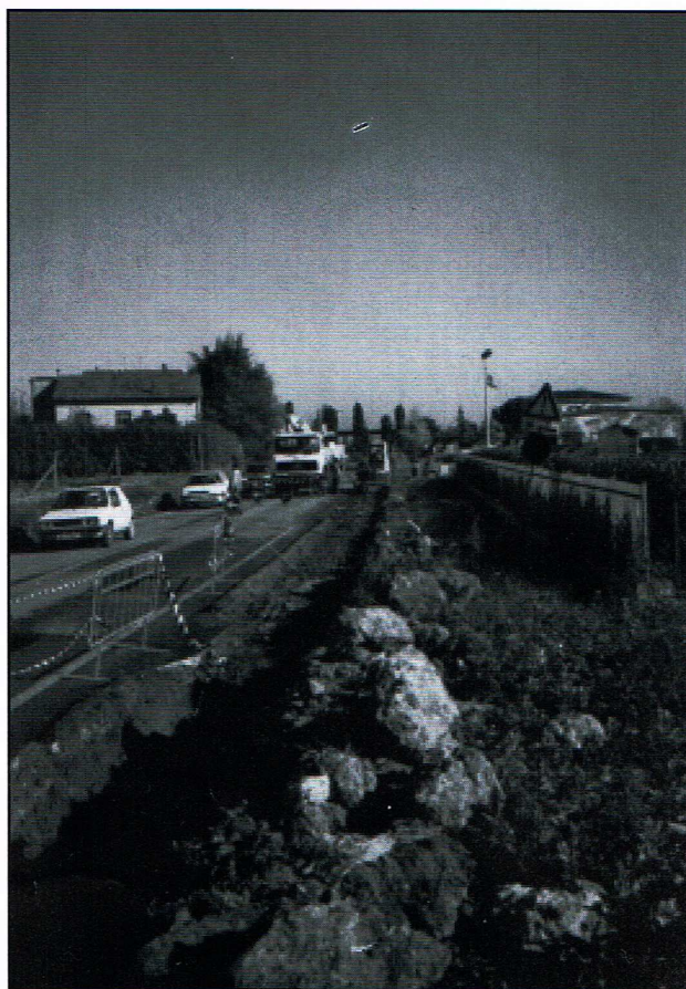
Il giorno d'inizio dei lavori
