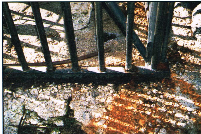
La Croce, come era il 10 Ottobre 2003. Evidente la ruggine che sta erodendo la struttura.
