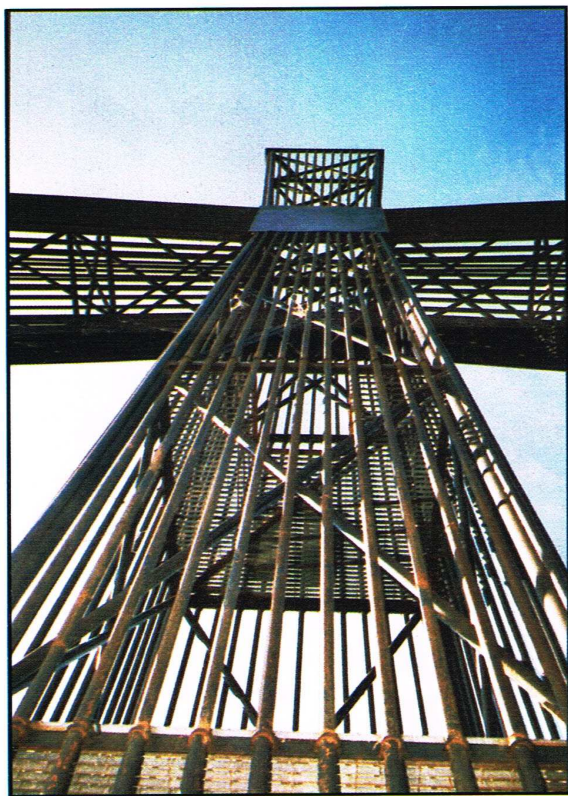
La Croce, come era il 10 Ottobre 2003. Evidente la ruggine che sta erodendo la struttura.
