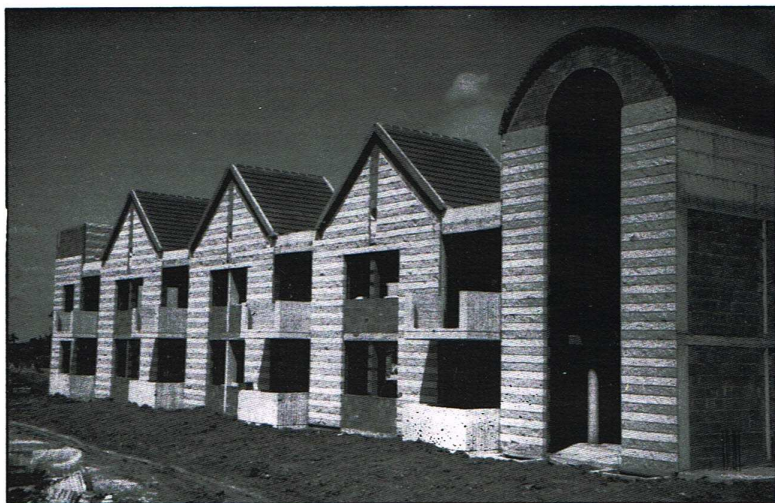
Casa di Riposo della Misericordia - 10 Marzo: sono stati completati i lavori del primo stato d'avanzamento consistenti nelle tramezzature e divisorii interni.
