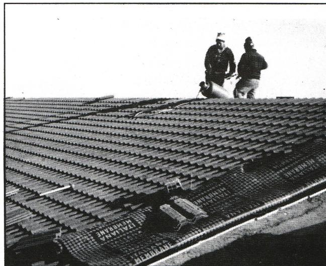
Costruenda Casa di Riposo (fine Gennaio): dopo la sistemazione sugli spioventi del tetto in lamiera zincata di isolante, impermeabilizzante e gettata in cemento, è il momento della messa in opera delle tegole che completeranno la copertura.
