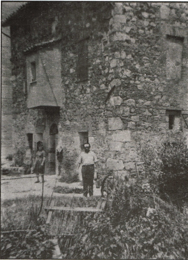
Il podere "Via di Fuori", popolarmente detto podere di Ventuno, demolito a spese della Parrocchia di San Lorenzo (alla quale apparteneva) per far posto all'attuale slargo all'inizio del Viale del Turismo.
