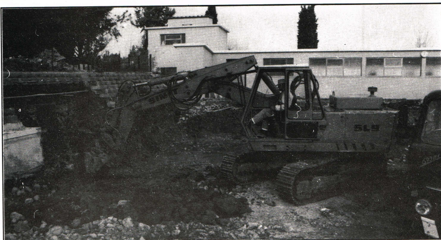
La "cascata" come era e durante i lavori di ristrutturazione
