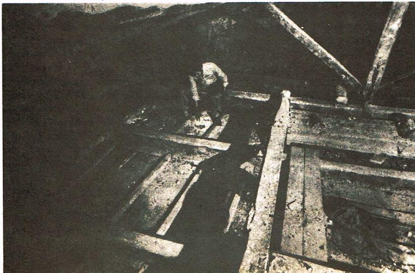
La chiara struttura a sostegno del soffitto, costituita da travi lignee di varia lunghezza, semplicemente appoggiate sui bordi del tamburo superiore, e da elementi secondari pure in legno. Il saggio indicato nella foto ha permesso di rilevare spessori e consistenza del soffitto.
