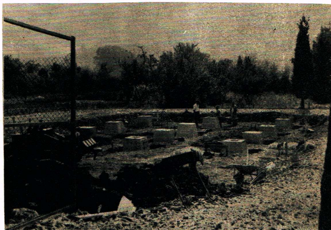
Le fondamenta del nuovo Ufficio
